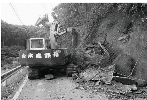
千葉県建設業協会による道路啓開(千葉県大多喜町)
