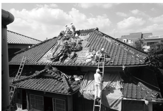
千葉県建設業協会会員による屋根ブルーシート張り (千葉県内)
