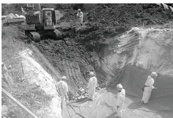
埋却溝掘削作業（埼玉県建設業協会）
