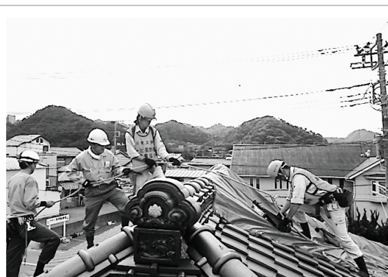
長野県建設業協会会員による屋根ブルーシート張り (千葉県鋸南町)
