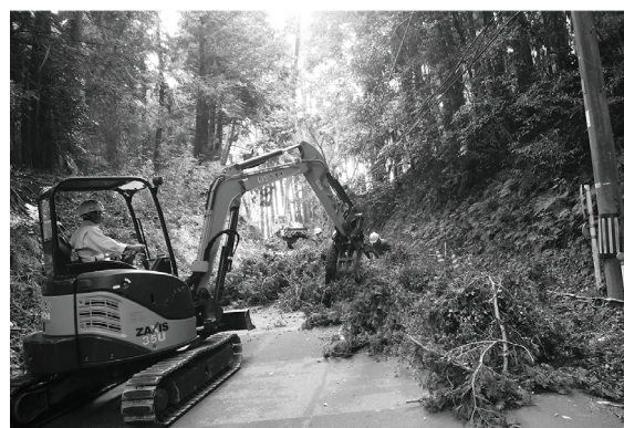
千葉県建設業協会会員による倒木の対応 (千葉県内)
