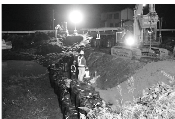
宮城県建設業協会による河川堤防緊急応急 (宮城県津山町)
