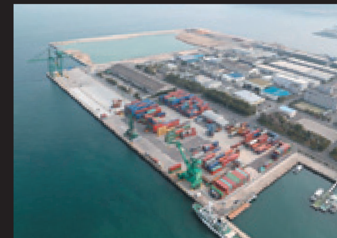
高松港コンテナターミナル整備(高松市)
