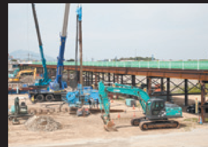
県道普通寺綾歌線 中方橋災害復旧(丸亀市)
