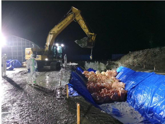
鳥インフルエンザの防疫措置に伴う埋却作業 (上段)令和8年3月宮城県角田市 宮城県建設業協会 (下段)令和8年1月香川県東かがわ市 香川県建設業協会
