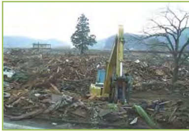
陸前高田市 道路開通作業(岩手県建設業協会)
