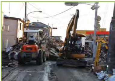
旭市 瓦礫撤去作業(千葉県旭市提供)
