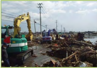
仙台市 道路開通作業(宮城県建設業協会)
